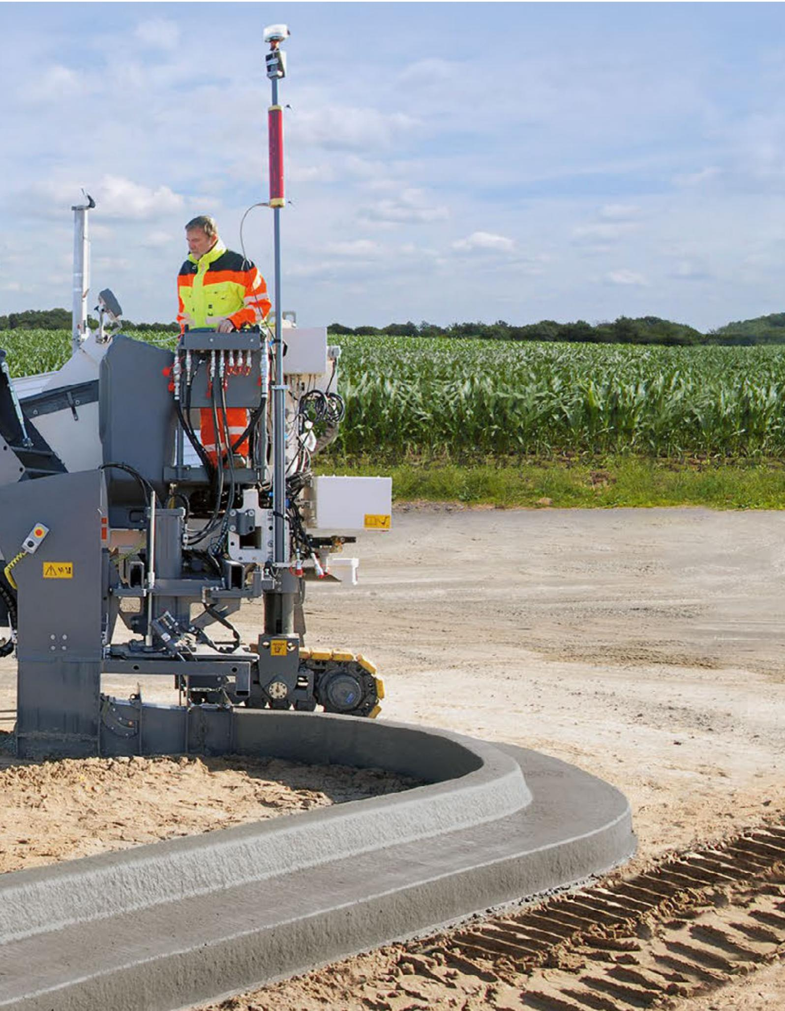
A pavimentadora de concreto compacta pavimenta uma ampla variedade de perfis monolíticos de até 1,3 m de altura. Superfícies de concreto de até 2,2 m de largura de pavimentação podem ser produzidas sem nenhum problema (não pode ser combinada com todas as opções). A pavimentadora de concreto é destinada a obras em que um alto grau de manobrabilidade, raios estreitos e máxima flexibilidade são necessários.
