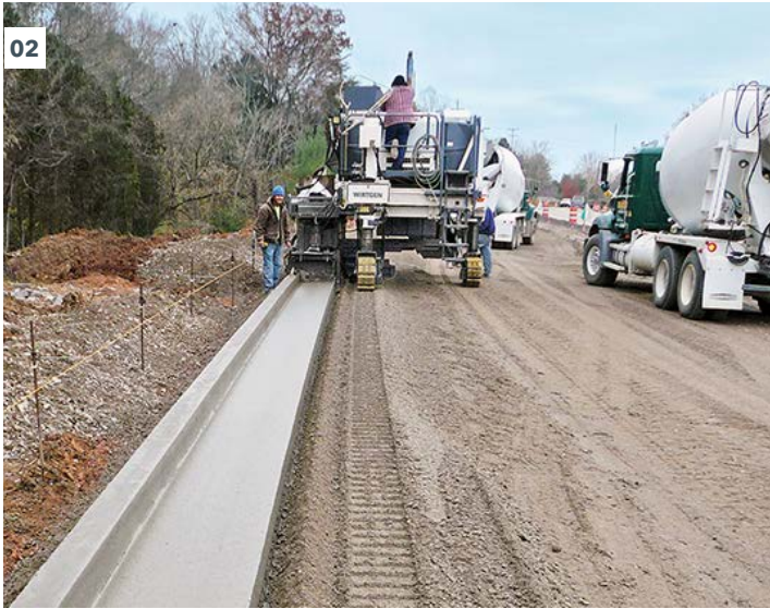
01 Selbstentwickelte Software sorgt für hohe Betriebssicherheit. 02 - 03 Die hochwertige Maschinensteuerung garantiert absolute Geradeausfahrt wie auch präzise Kurvenfahrt. 04 Separate Ventile an allen Fahrwerken für hochpräzise Ansteuerung von Höhenverstellung und Lenkung.
