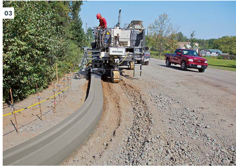
01 Selbstentwickelte Software sorgt für hohe Betriebssicherheit. 02 - 03 Die hochwertige Maschinensteuerung garantiert absolute Geradeausfahrt wie auch präzise Kurvenfahrt. 04 Separate Ventile an allen Fahrwerken für hochpräzise Ansteuerung von Höhenverstellung und Lenkung.
