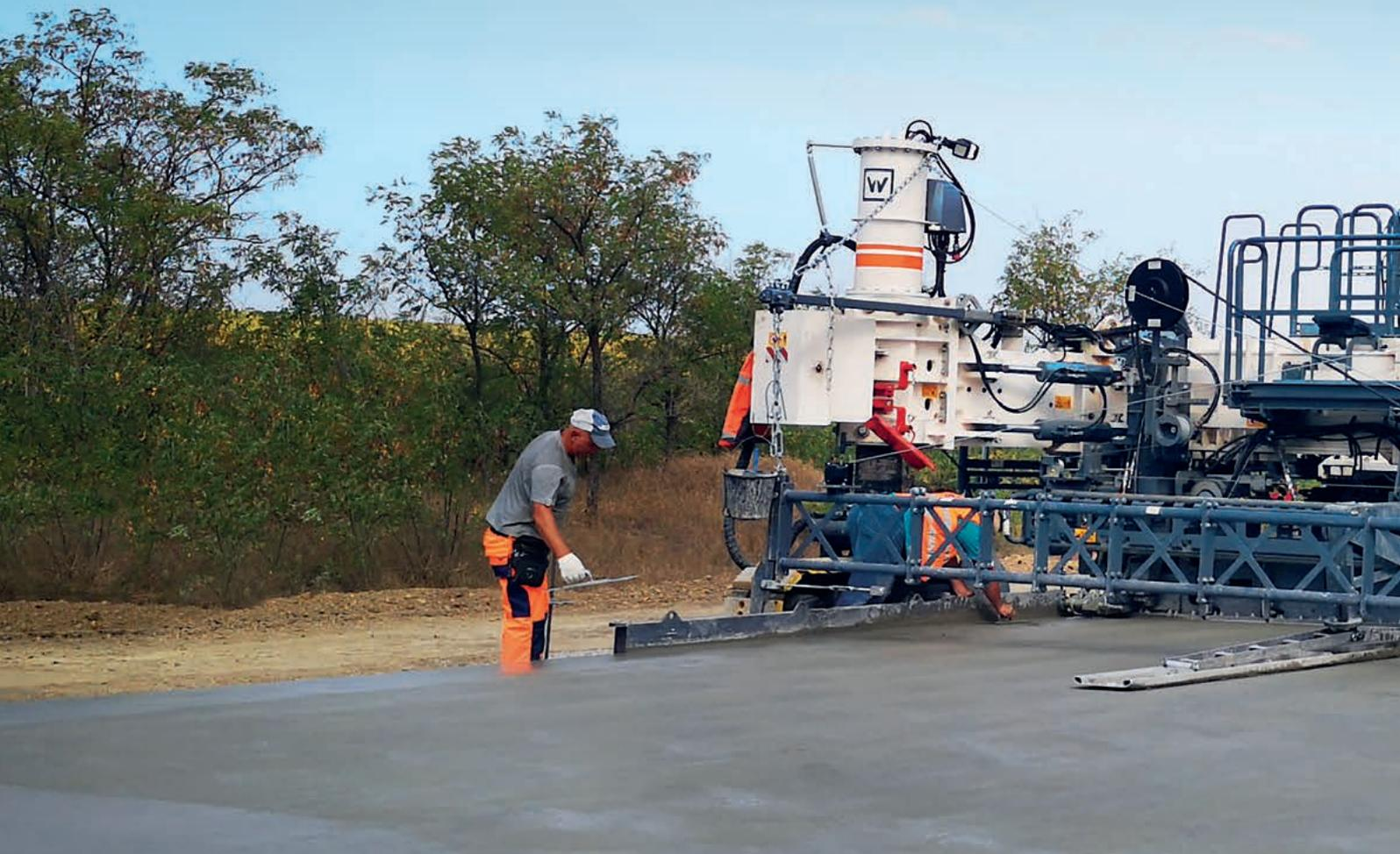
Der Inset-Gleitschalungsfertiger eignet sich optimal für die wirtschaftliche Fertigung großer Betonflächen von 4,5 m bis zu 12,0 m Breite und 450 mm Dicke.
