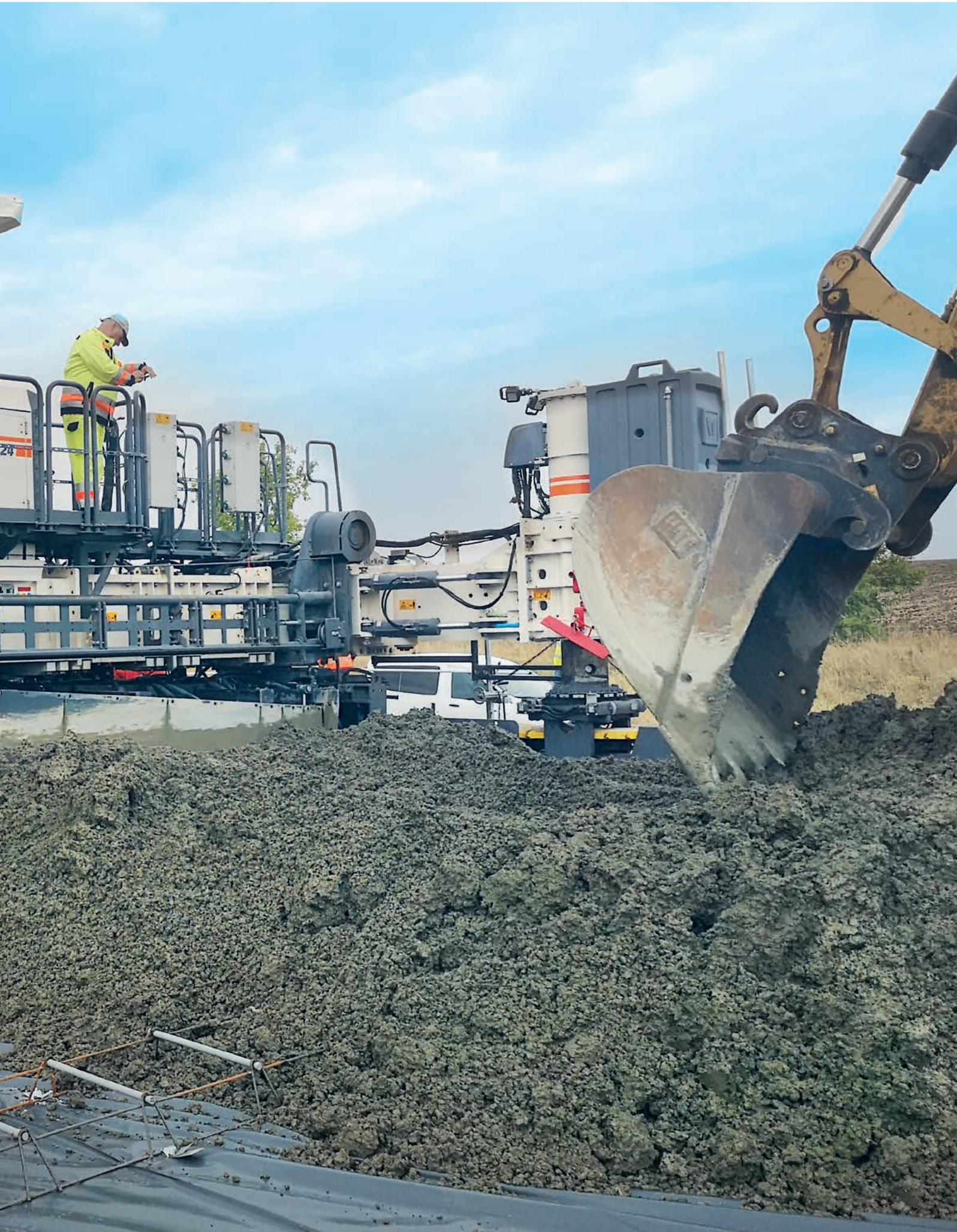
Der Inset-Gleitschalungsfertiger eignet sich optimal für die wirtschaftliche Fertigung großer Betonflächen von 4,5 m bis zu 12,0 m Breite und 450 mm Dicke. Durch den in Längsrichtung hydraulisch und in Querrichtung mechanisch teleskopierbaren Maschinenrahmen ist der Gleitschalungsfertiger optimal an jede Baustellensituation anpassbar. Standardmäßig vier hydraulische Schwenkarme vereinfachen den Maschinentransport und bieten hohe Anpassungsfähigkeit an jede Baustellensituation.
