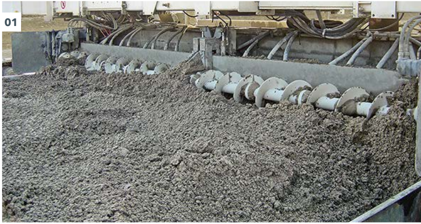
01 - 02 Inset-Verfahren: Ausbreiten des Betons mit Verteilerschnecke oder -schwert.
