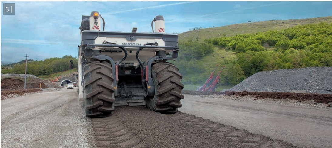
2-3 | Enrobé traité de manière homogène derrière le recycleur à froid.
