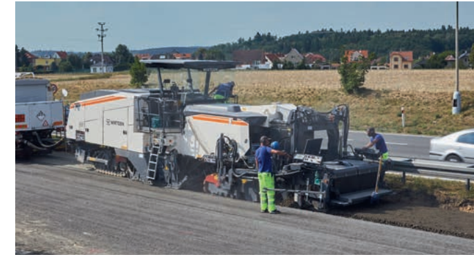
W 240 CRi mit Einbaubohle bei 2,35 m Arbeitsbreite
