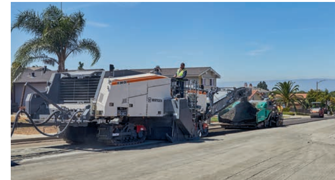
W 380 CRi mit Abwurfband bei 3,8 m Arbeitsbreite inkl. Fertiger
