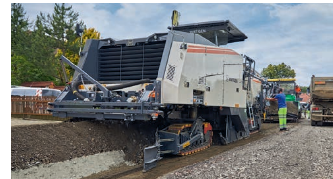
W 240 CRi bei gesamter Fahrbahnbreite inkl. seitlichem Vorfräsen und Fertiger
