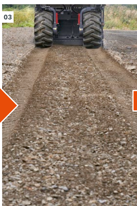
03 Resultado de la trituración y la mezcla: evaluación y reajuste de los parámetros según las necesidades.
