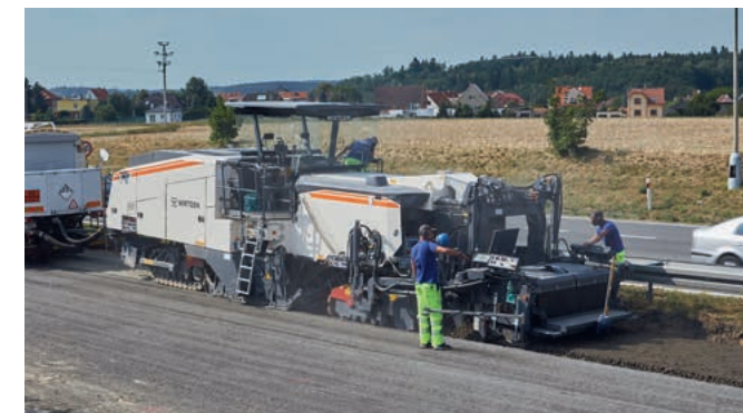
W 240 CRi con banco di stesa e con una larghezza operativa di 2,35 m
