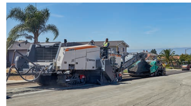
W 380 CRi con nastro di scarico e con una larghezza operativa di 3,8 m, finitrice inclusa
