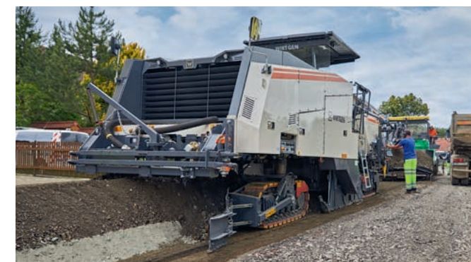
W 240 CRi sull'intera larghezza del piano viabile, pre-fresatura laterale e finitrice inclusa
