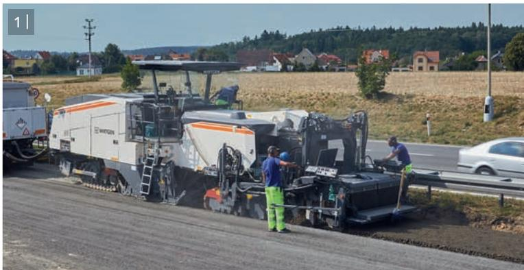
1 | *Reciclaje en frío in situ con la recicladora en frío W 240 CRi y regla de extendido integrada.*
